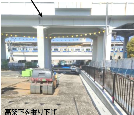
高架下を掘り下げ
