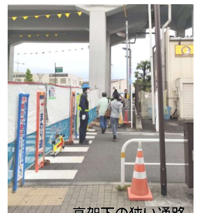
高架下の狭い通路
