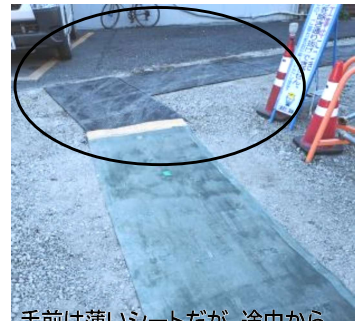
手前は薄いシートだが、途中から厚みのあるシートに交換されている
