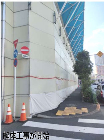
解体工事が開始
