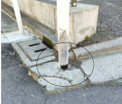
「カーブミラーの根元が腐食していて倒れないか心配」とご相談が。担当課に連絡し、すぐに新しいものに交換されました。犬などのマーキングで腐食してしまうそうですが、こまめな点検を。
