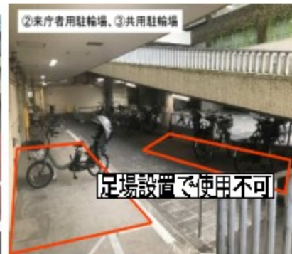
足場設置で使用不可
