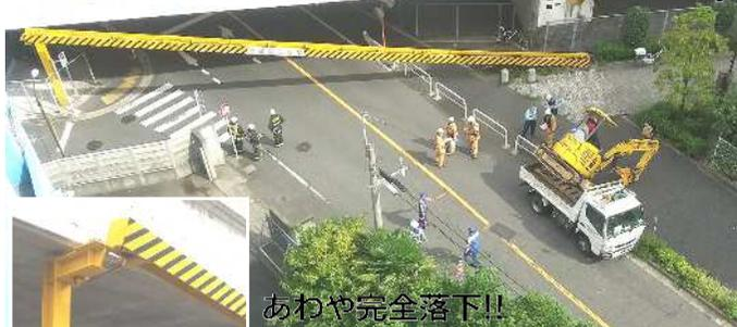
南千住7丁目～汐入のJR常磐線の高架で事故が。高さ制限を見落としたのか、荷台で運んでいたショベルカーが引っかかり、ガード用の鉄骨が落下。幸い負傷者などはおらず、数時間通行止めになったようです。中学校も近く、車の通行も多い
