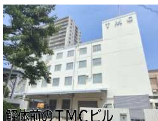
解体前のTMCビル
