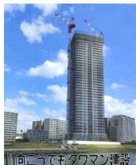
川向こうでもタワマン建設
