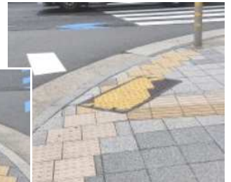
マンホールへの貼付けは 下水道局との協議も必要
