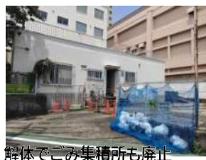
解体でこみ集積所も廃止
