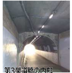
第3架道橋の内部
