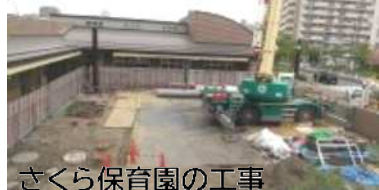
さくら保育園の工事
