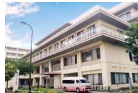
リバーサイド病院(インターネットより)
