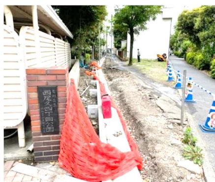
明治通り側からみた工事現場
