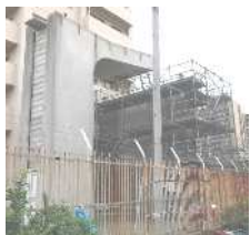
橋の真ん中解体
