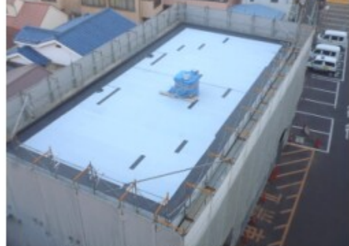
工事半ばの本庁舎倉庫屋上
