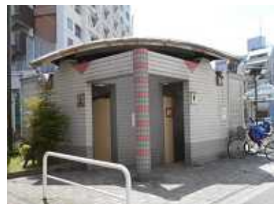
解体前のトイレ
