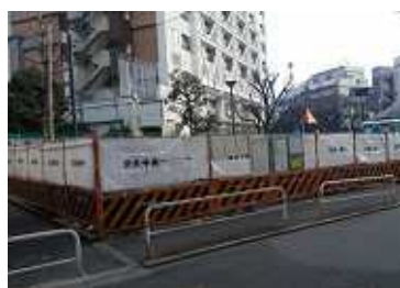
解体されたトイレ
